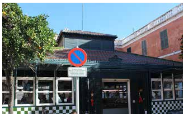
L'estructura i el disseny del Mercat des Peix és una de les mostres més clares de l'arquitectura de ferro i vidre que tenim a Menorca.
